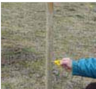
Instalación de aisladores para estacas de madera.
